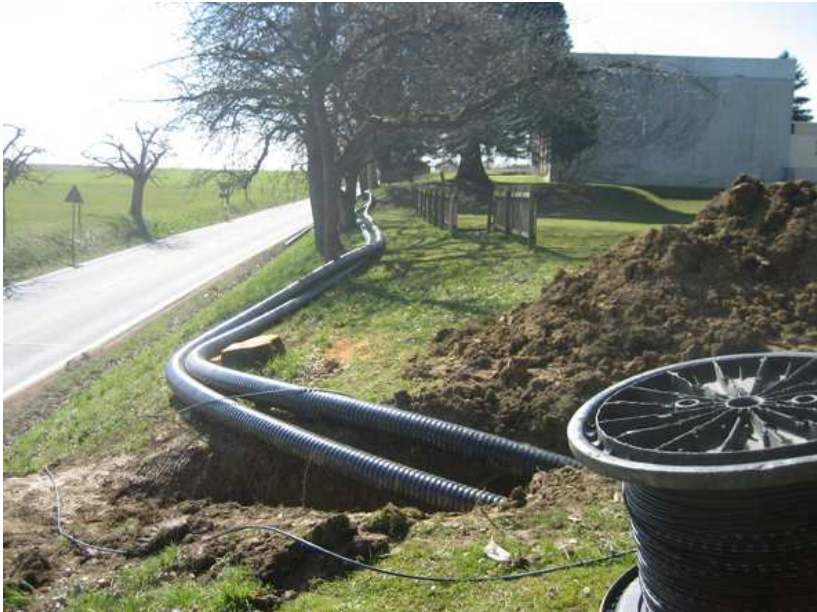
Nahwärmeleitung zwischen Wackenhausen und Lippertsreute
