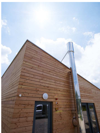
Blick auf die Heizzentrale
